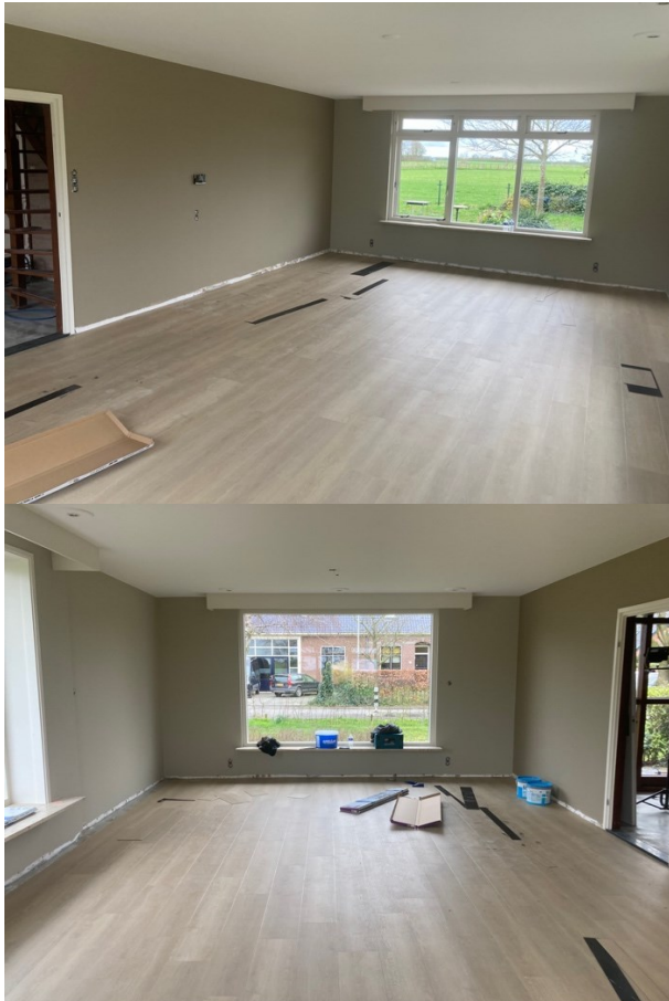
Schilderwerk, vloerafwerking woonkamer
