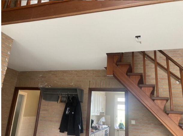
Gipsplafonds en schilderwerk in de hal
