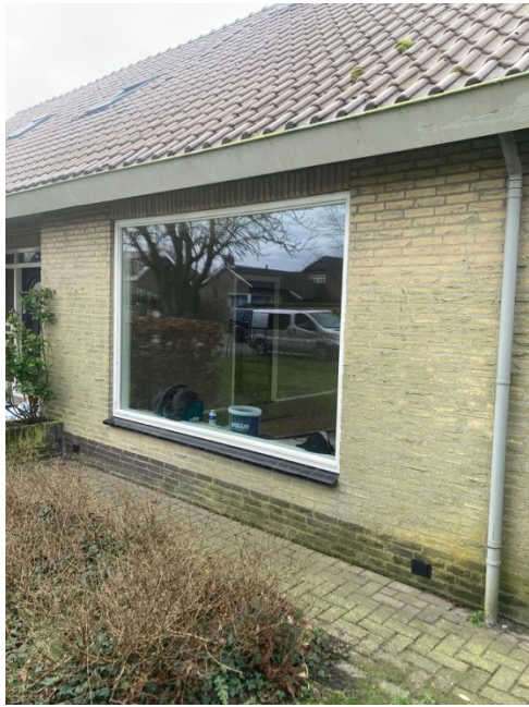
De nieuwe hr++ beglazing
